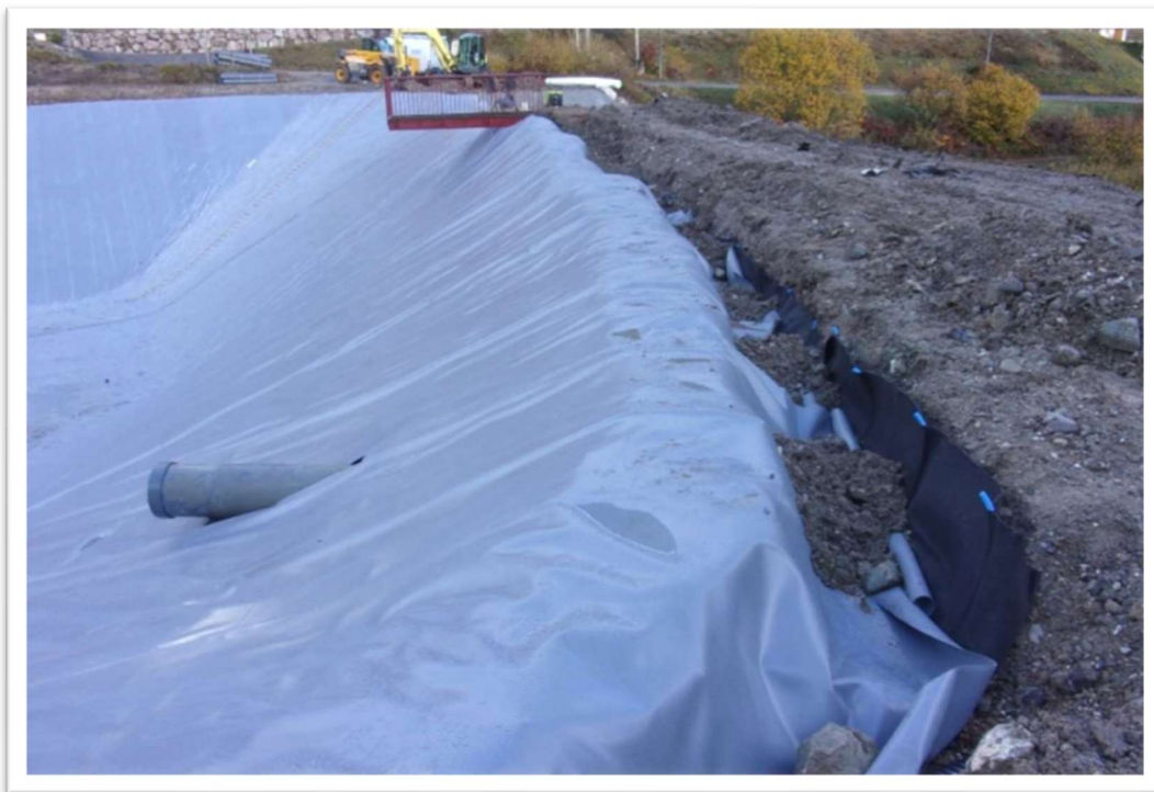
Fig. 27. Exemple de tranchée d'ancrage (source : Pyrite ingénierie).
